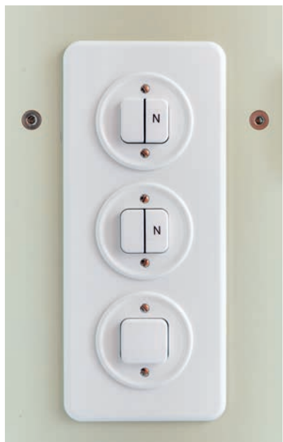
Benutzerfreundlich Drei konventionelle Taster steuern mit Hilfe einer Taster-Schnittstelle via KNX die DALI-Leuchten an. Das Nachtlicht ist markiert.
