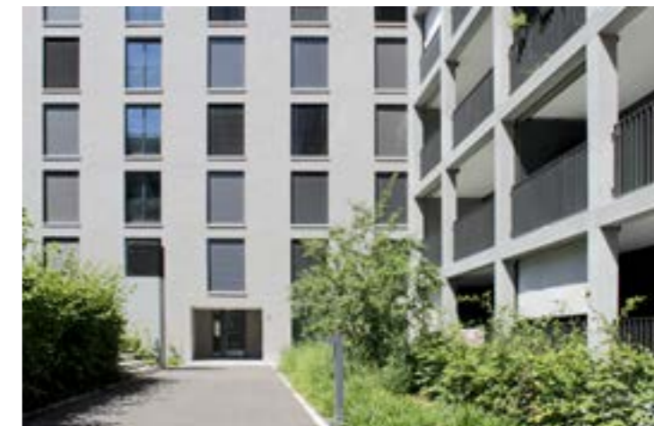
Abb. 1: Eingang Wohnsiedlung «Im Guss» mit Treppenhaus (mit Tageslicht).
