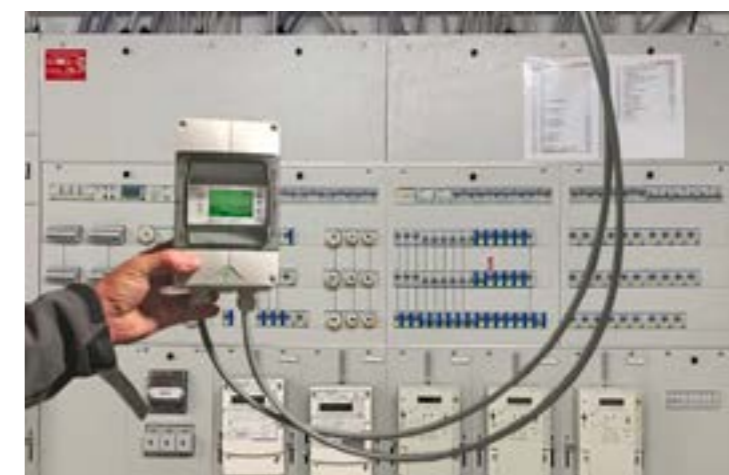
Abb. 3: Installation der Messgeräte in der Elektroverteilung.
