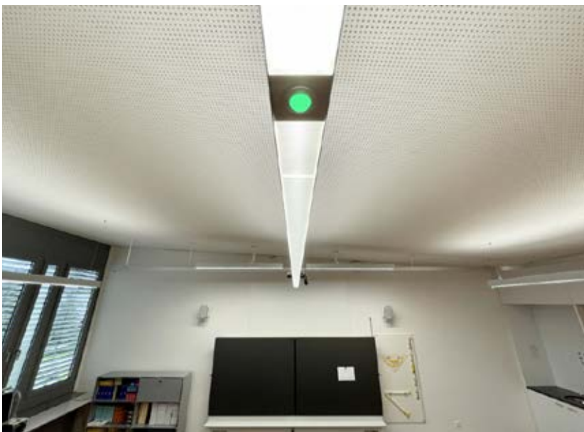
Gute Luft Leuchte mit integrierter intelligenter Lichtsteuerung inkl. Raumluftsensor.
