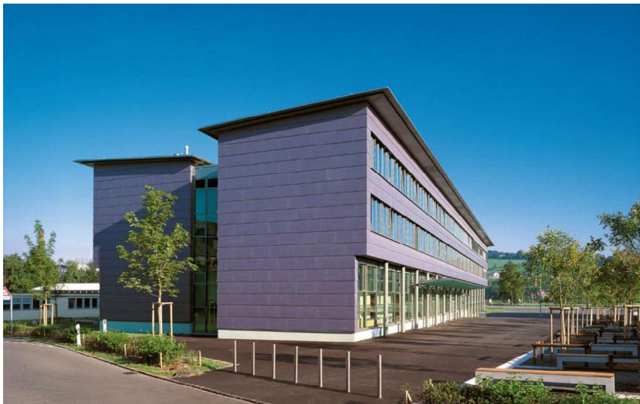
Figure 27 : Vue extérieure de l'école Sennweid, Baar (photo : archetage ag)
