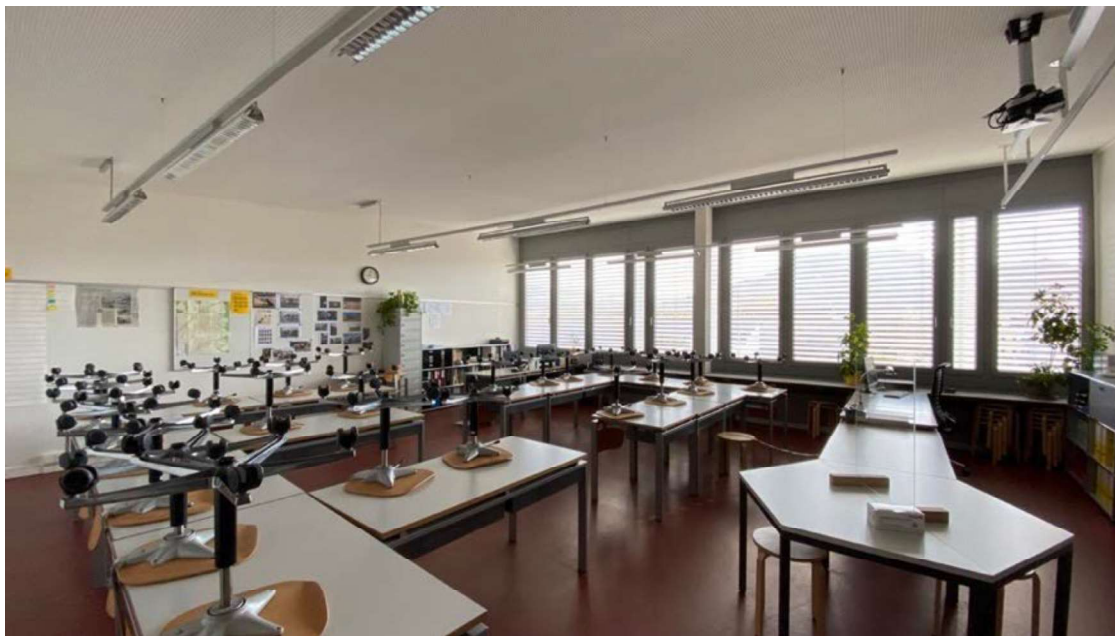
Figure 28 : Ancien éclairage dans la salle de classe de l'école Sennweid, Baar
