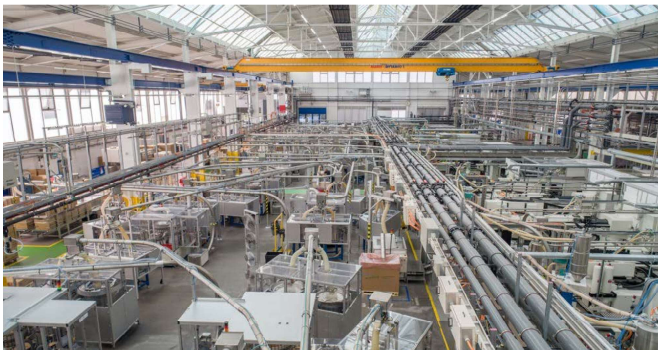
Figure 23 : Vue intérieure du hall industriel SIG AllCap, Neuhausen am Rheinfall (photo : Zumtobel)
