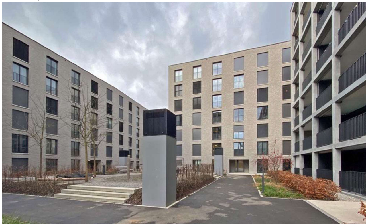
Figure 10 : Vue extérieure de l'ensemble d'habitation Im Guss, Bülach (photo : Stefan Gasser)
