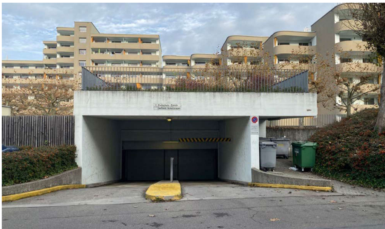
Figure 32 : Vue extérieure du parking souterrain Heuried, Zurich (photo : Stefan Gasser)
