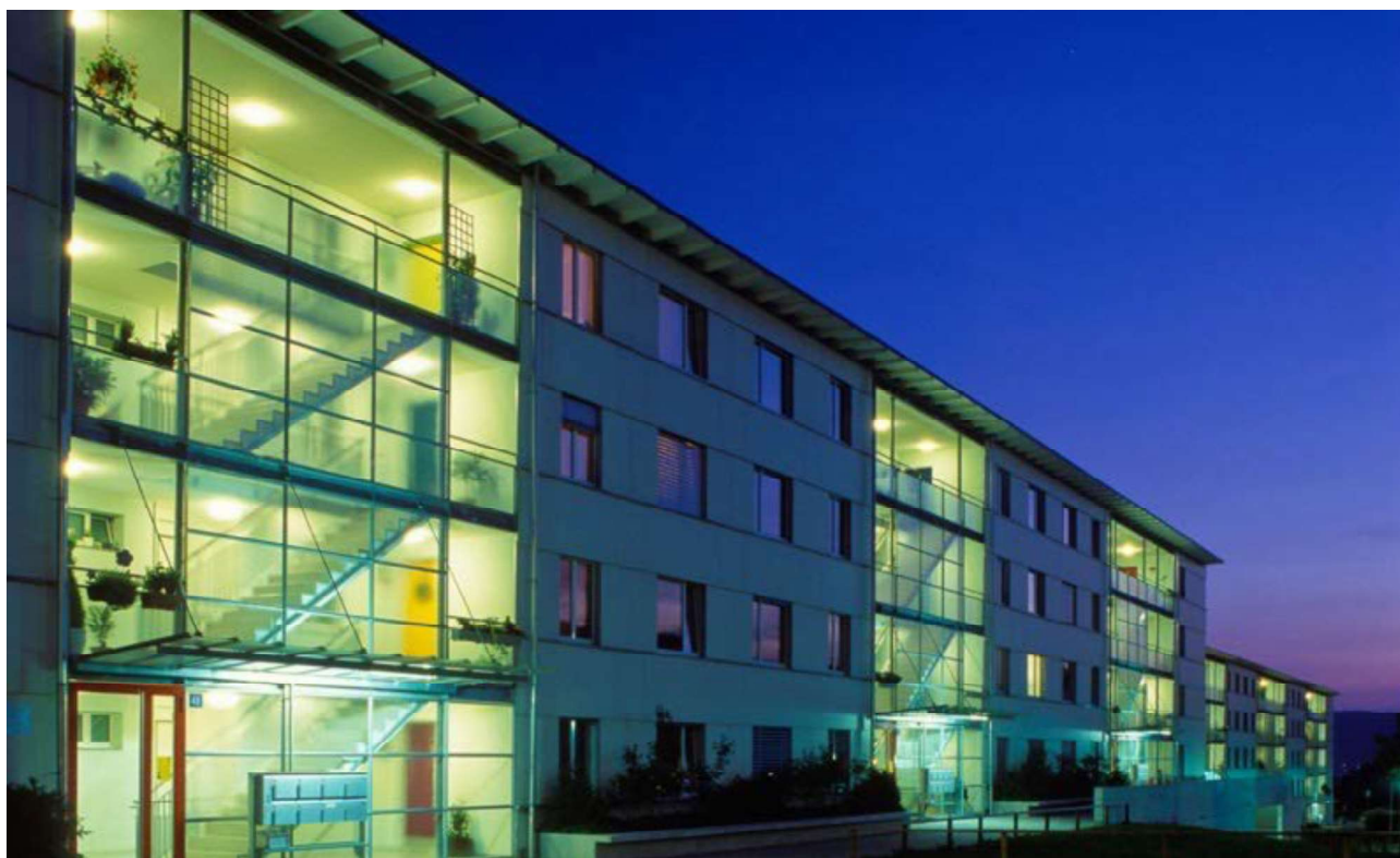
Figure 15 : Vue extérieure du lotissement Rütihof, Zurich-Höngg (photo ASIG)
