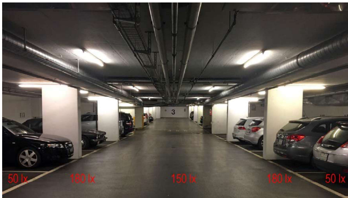
Figure 33 : Ancien éclairage dans le garage Heuried (avec éclairage)
